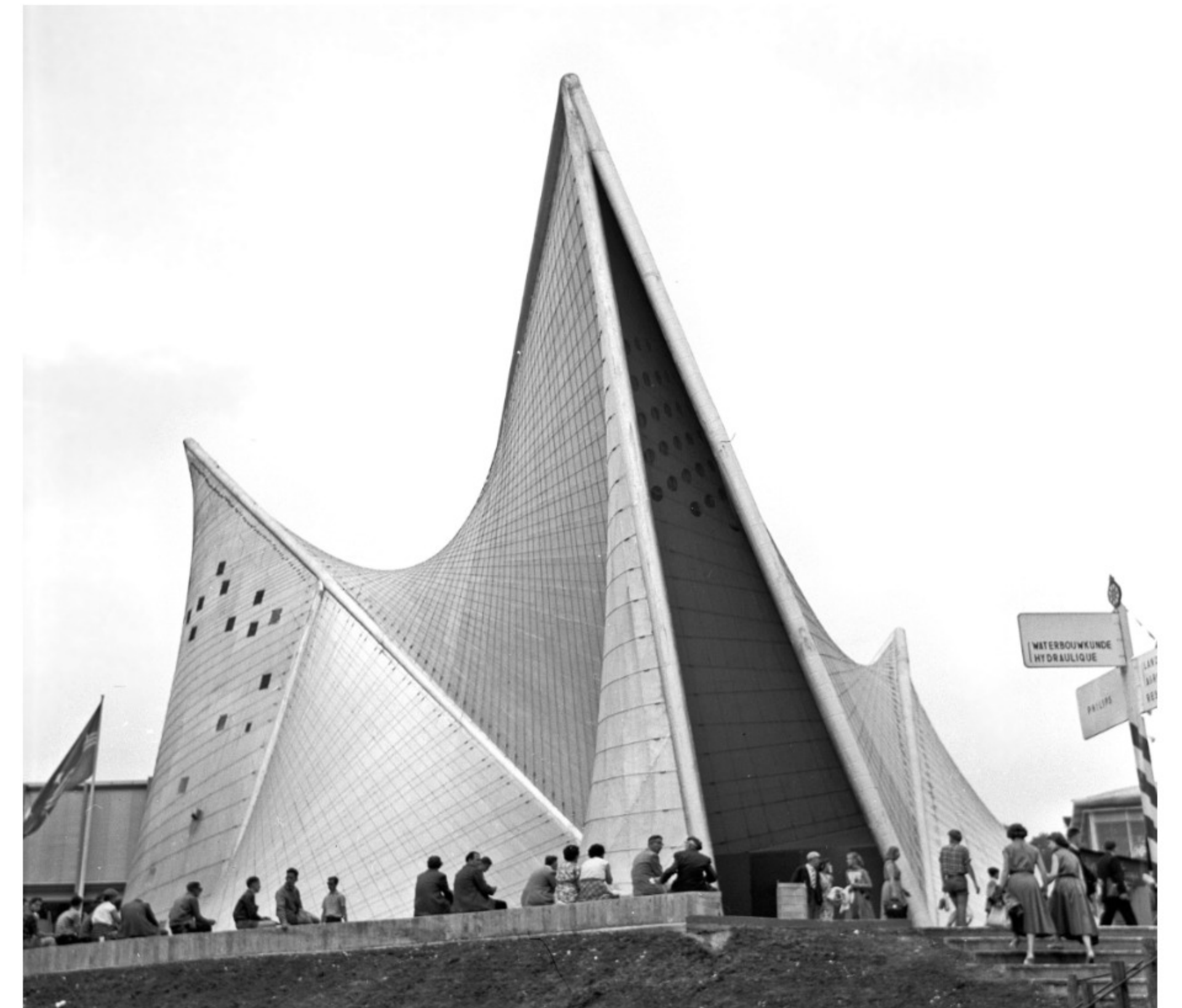
Pavillon Philips (Le Corbusier / Xenakis) Edgard Varèse Poème électronique Xenakis Concret PH - paraboloides hyperboliques
